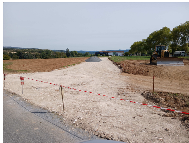
Viabilisation du lotissement « le Clos de Brennus » (opération privé)
