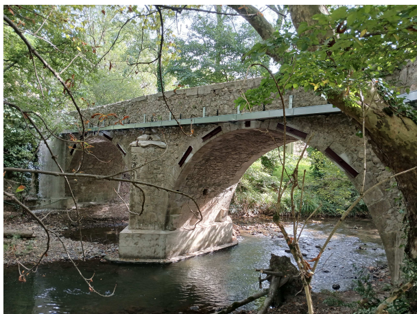
Confortement Pont de Gaix
