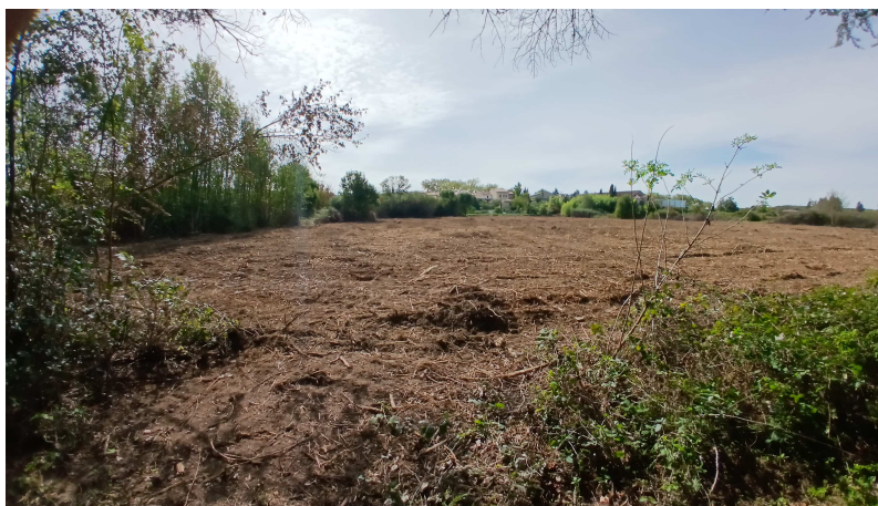
Défrichement d'une parcelle à « Moreau » pour futures plantations ( paulovnia ) dans le cadre de l' Hydrologie régénératrice : Ralentir, Répartir, Infiltrer et Stocker toutes les eaux de pluie et de ruissellement
